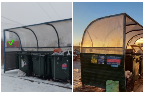
Замена торцевого участка крыши контейнерной
