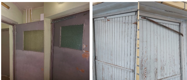
Ремонт дверей с установкой пружин
